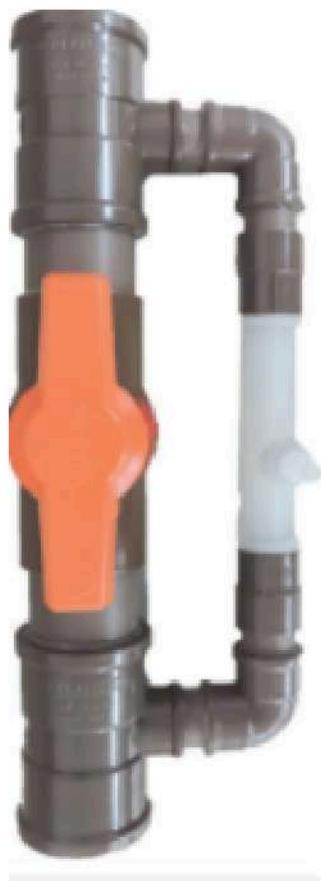
Figura 18 – Tubulação de instalação do O3 Tecnologia Panazon (2025)
