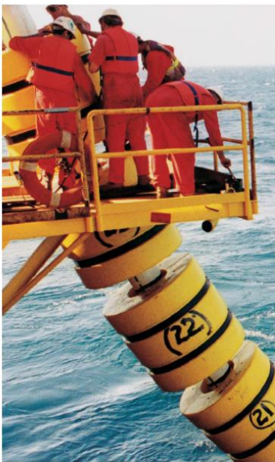
Figura 19 - Instalação de flutuadores no riser
