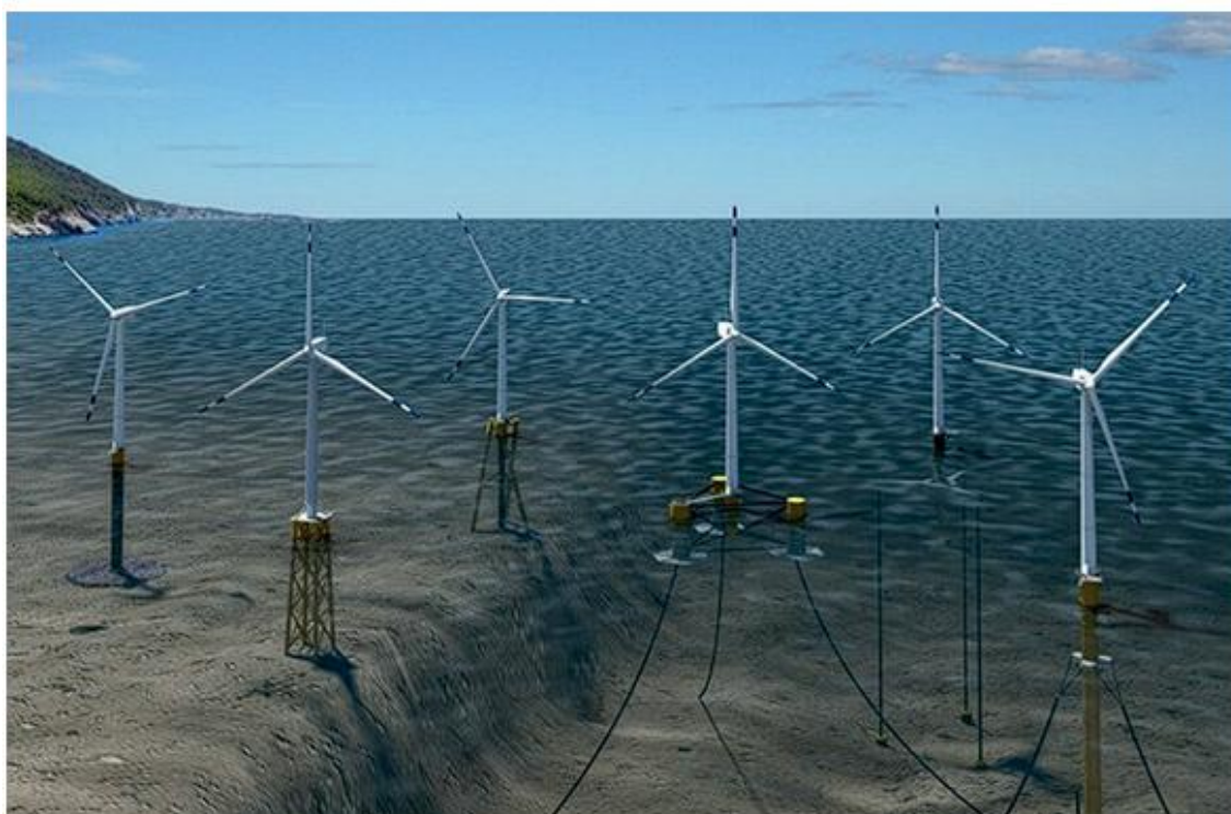
Figura 15 - da esquerda para a direita: monoestaca, jaqueta, jaqueta torcida, plataforma semissubmersível, plataforma flutuante taut-leg e mastro-boia. Fonte: CNI, (2023).
