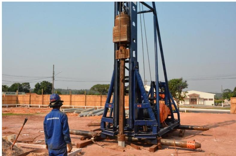
**Figura 13 - Bate-estacas em operação**
